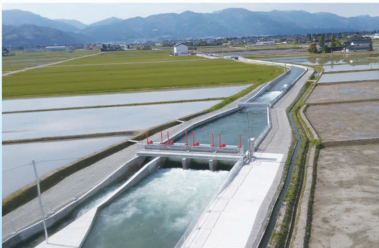
▲完成した新明分水場と奥に見える 新明発電所(砺波市新明地内)
