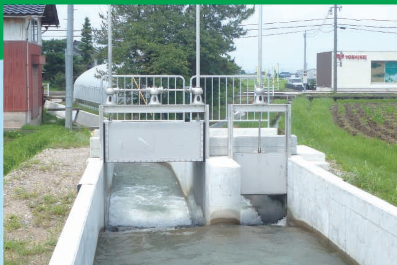
▲完成した上若林口用水路の西中野分水場(砺波市中野地内)
