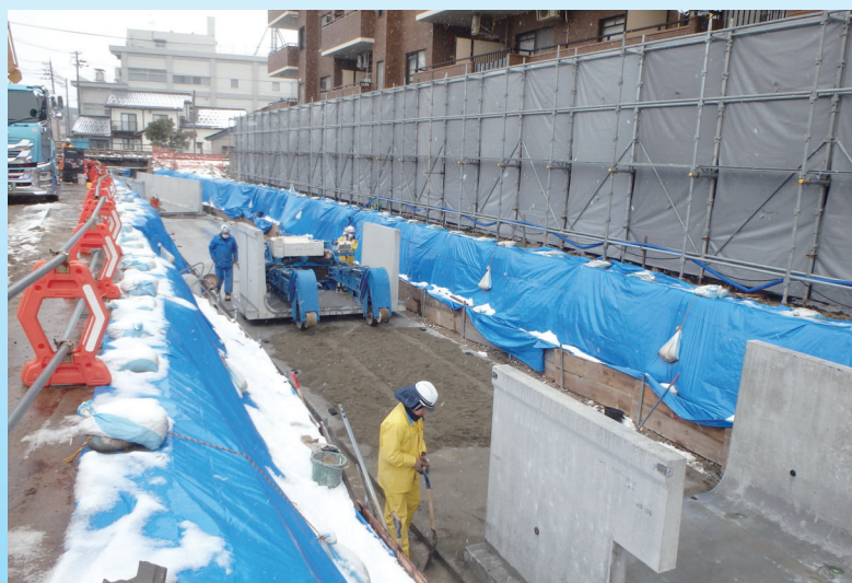
▲附帯県営農地防災事業リフトローラー工法による施工ヶ所 若林口用水路(砺波市一番町・山王町地内)
