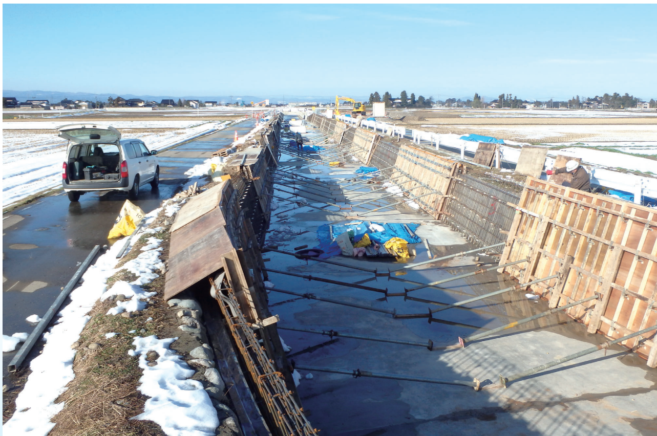
▲庄西幹線水路を県営農業水利施設整備事業により改修(砺波市中野地内)
