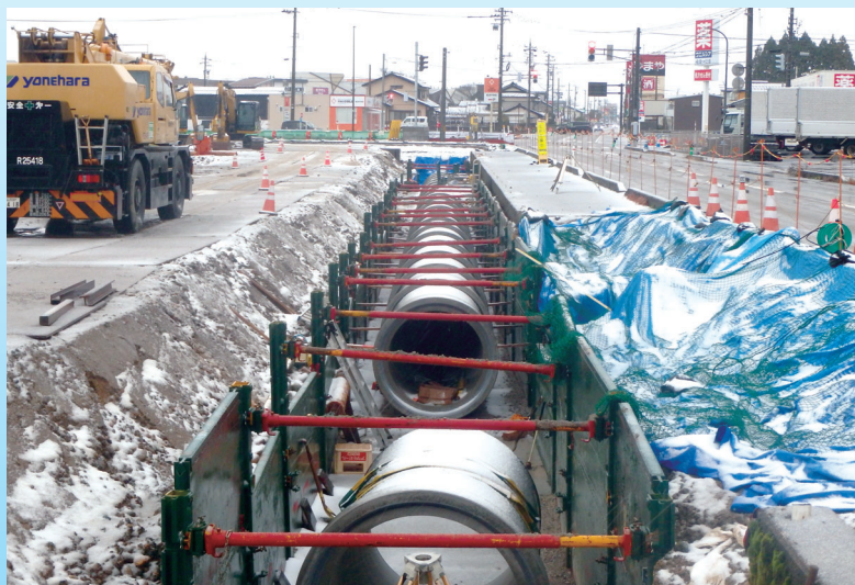
▲附帯県営農地防災事業により上黒石川排水路の管路を布設中 (砺波市中神地内)
