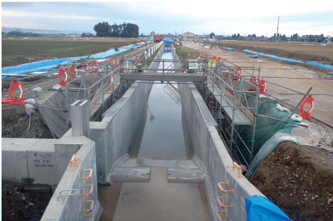
▲千保口用水路を県営農業水利施設整備事業により改修中(砺波市太田地内)
