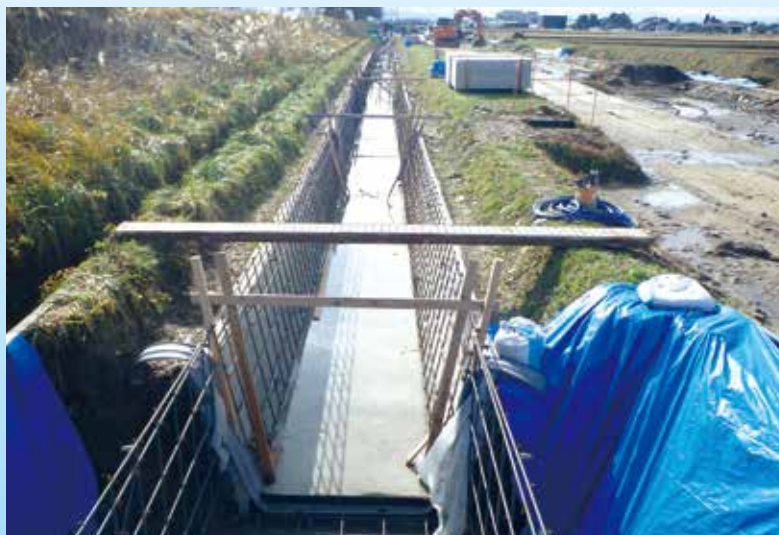
▲太田口用水路を県営水利施設整備事業により改修中（砺波市太田地内）
